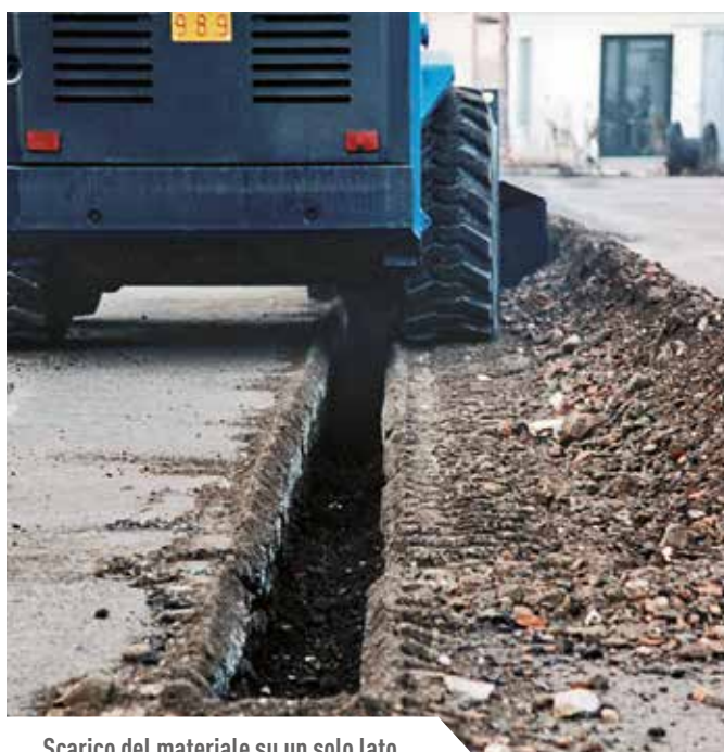
Scarico del materiale su un solo lato
